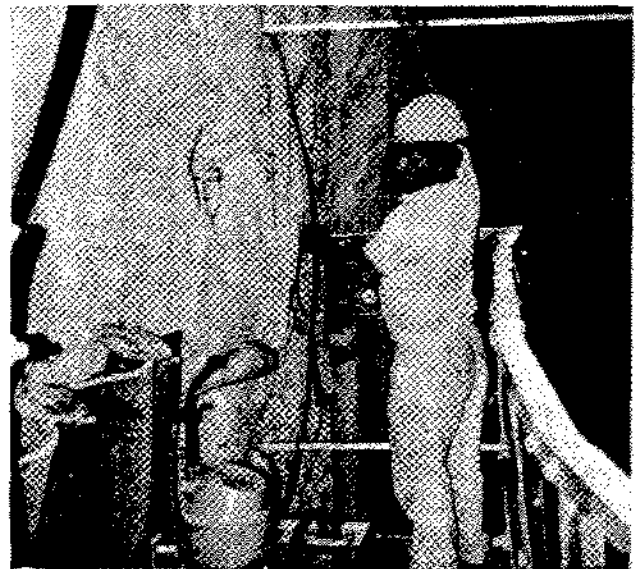
Figur 17. Ultraschallmessungen in situ .
